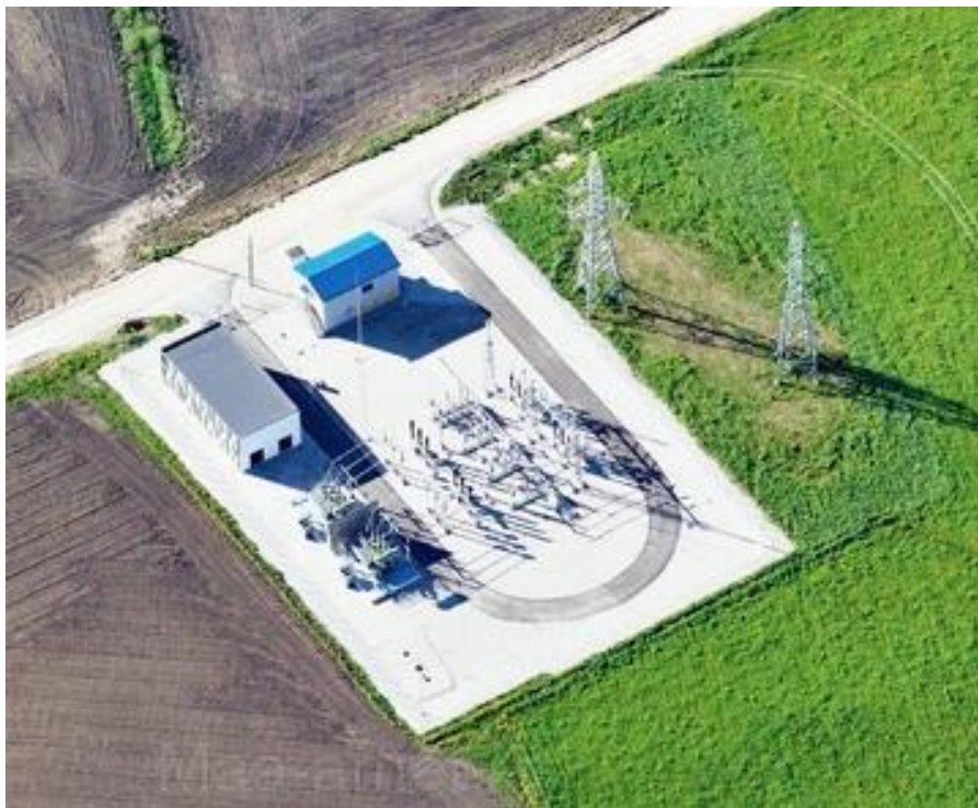
Figure6 . 110 kV apakšstacijas ilustrācija – Jāneda apakšstacija. Avots: Zemes pārvalde Kaldaerofoto.
