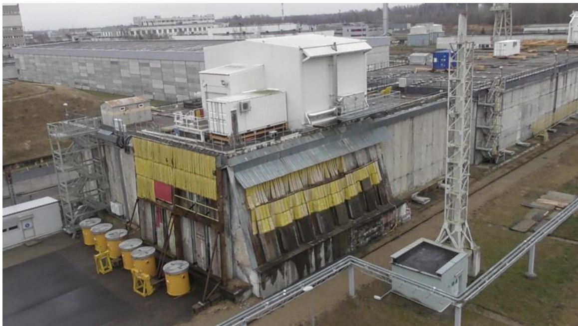
Attēls 3-1. Uzglabāšanas ēka nr. 157 IAES darbības SRW ar G3 3. grupas SRW izņemšanas vienību RU-3
