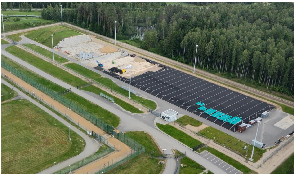
Attēls 3-4. VLLW krātuves modulis ar inženiertehniskajām barjerām un aizsargsienu, kas izveidota pēc konkrētas iekraušanas kampaņas
